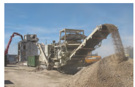
Mobiler Brecher für Bauabfälle
