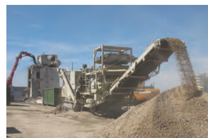
Mobiler Brecher für Bauabfälle
